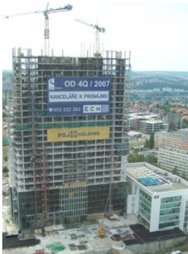
CITY TOWER – čilý stavební ruch / červen 2007
